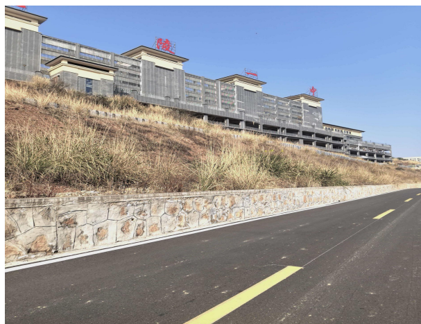
城南污水处理厂出水 2#泵站西侧沅陵一中 附图 17 现场照片 2
