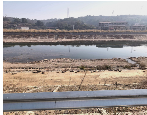
城南污水处理厂 1#、2#泵站东侧蓝溪河
