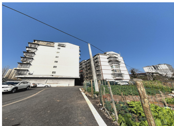
城南污水处理厂 2#泵站西侧居民点
