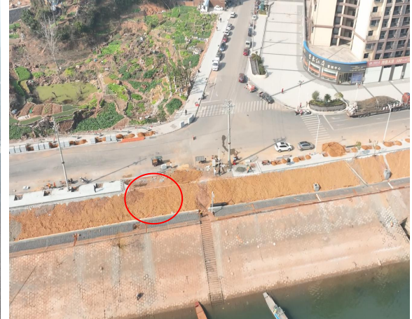
城北污水处理厂出水 1#泵站用地现状
