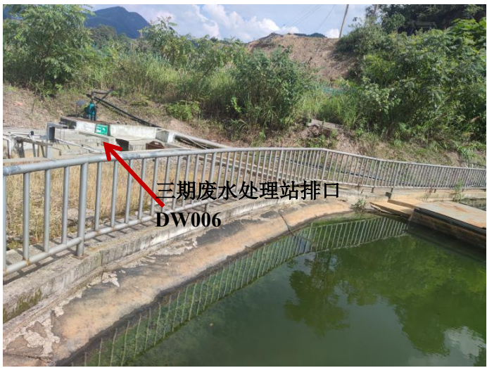
附图 7 三期废水处理站排口情况图
